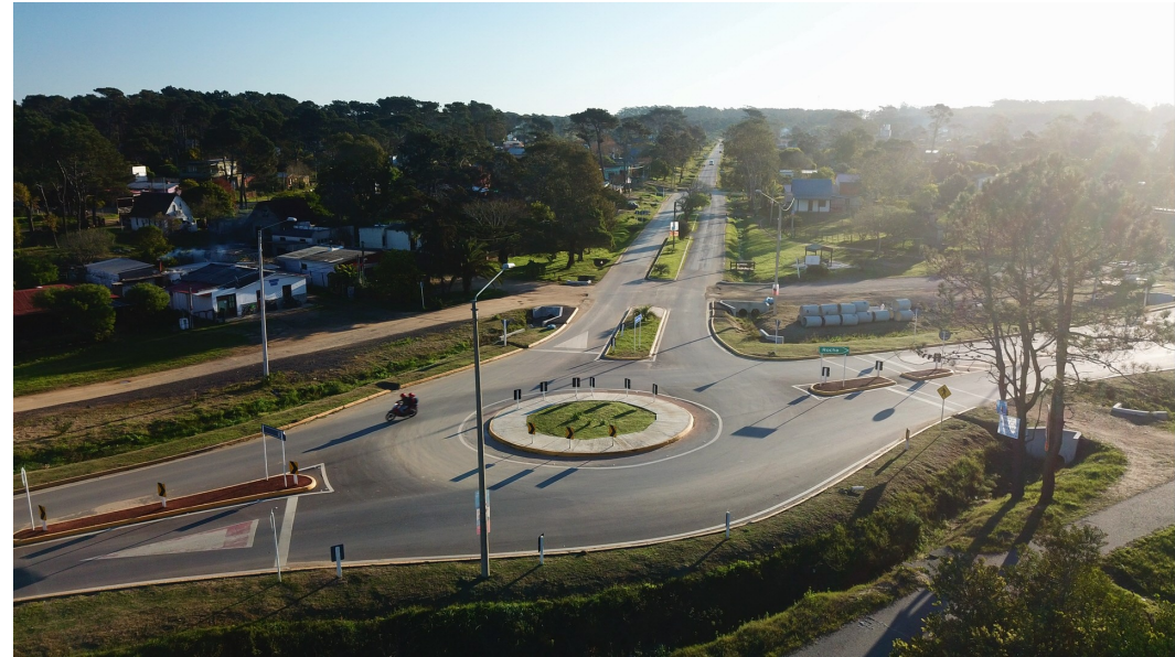
LA PALOMA - ACCESO BARRIO PARQUE DESDE RUTA 15
