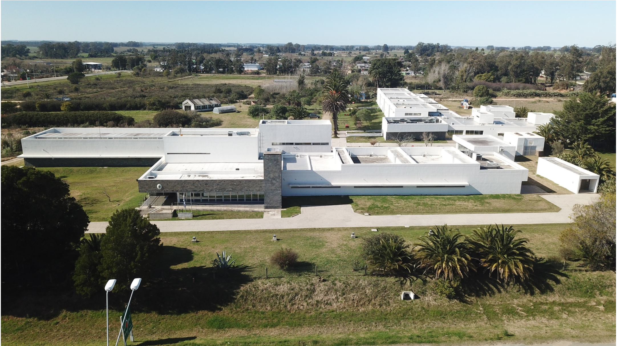
CENTRO UNIVERSITARIO REGIONAL ESTE - OBRA DE UNIVERSIDAD DE LA REPUBLICA
