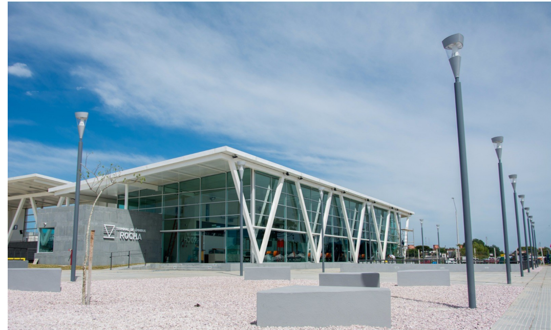
ROCHA - TERMINAL DE OMNIBUS
